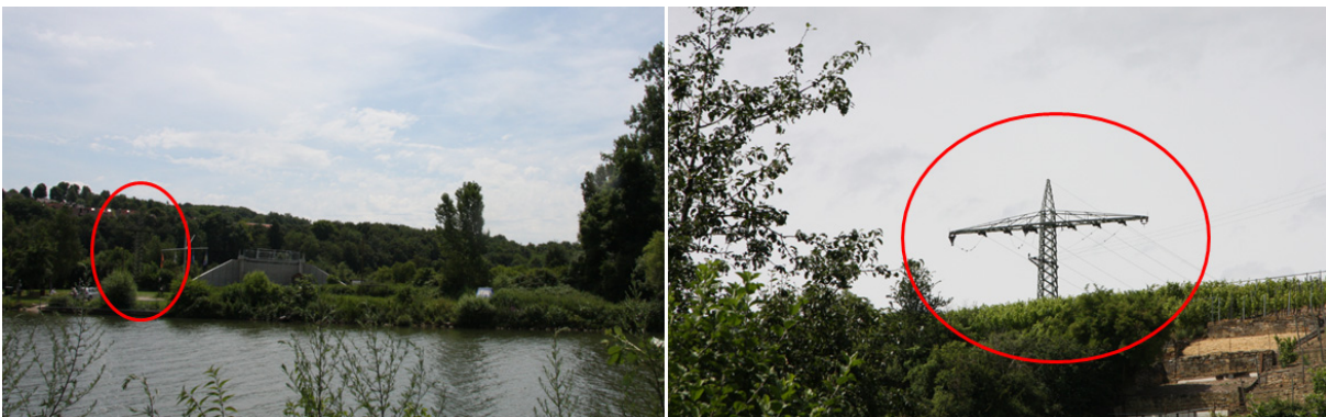
Ansicht der beiden Strommasten im Bereich des Freileitungsdurchflugs
