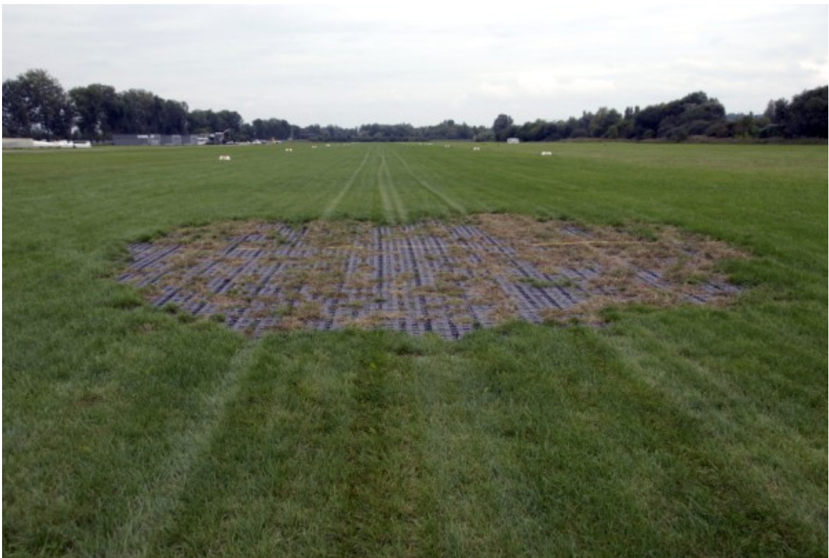
Verlegte PSP-Platten auf der Piste
