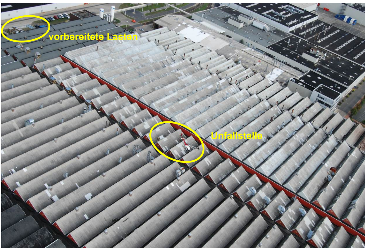
Übersicht Aufnahmeort, Ablageort und Unfallstelle auf dem Sheddach
