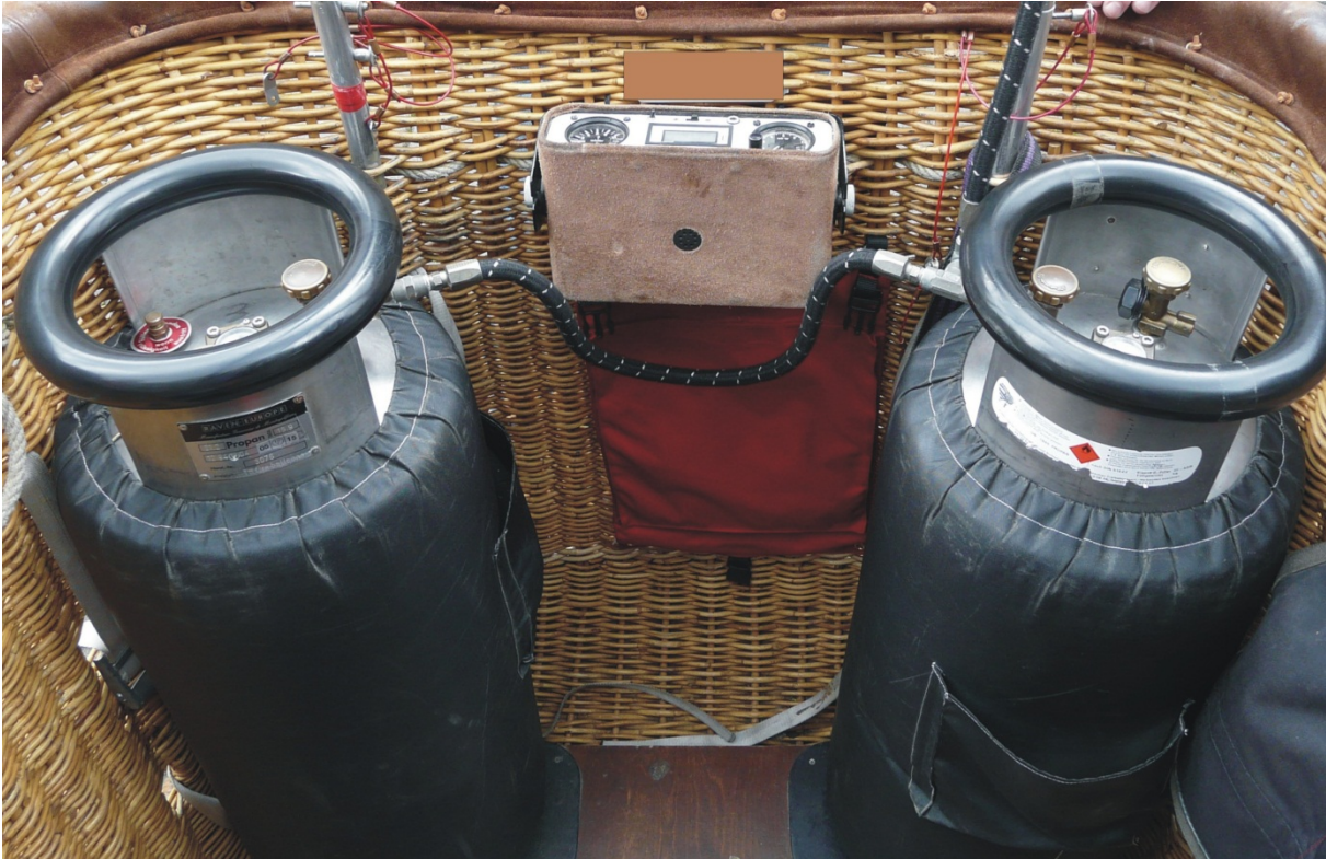
Gasbehälter mit montierter Gasverbindungsleitung
