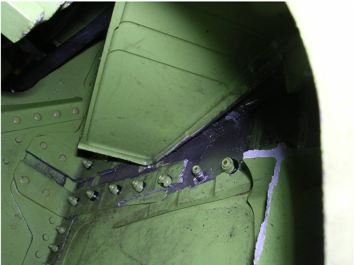
Bild 1: Rechte Tragfläche, herausgerissener Support Fitting
