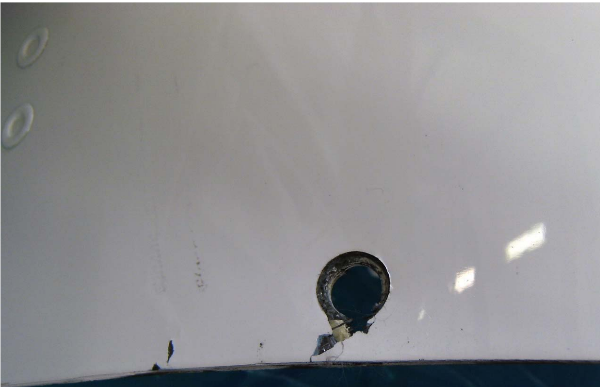
Teil der Cowling mit beschädigten Befestigungselementen
