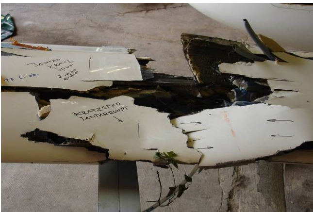
Abb. 5 Ventus Bruchstelle des linken Tragflügels
