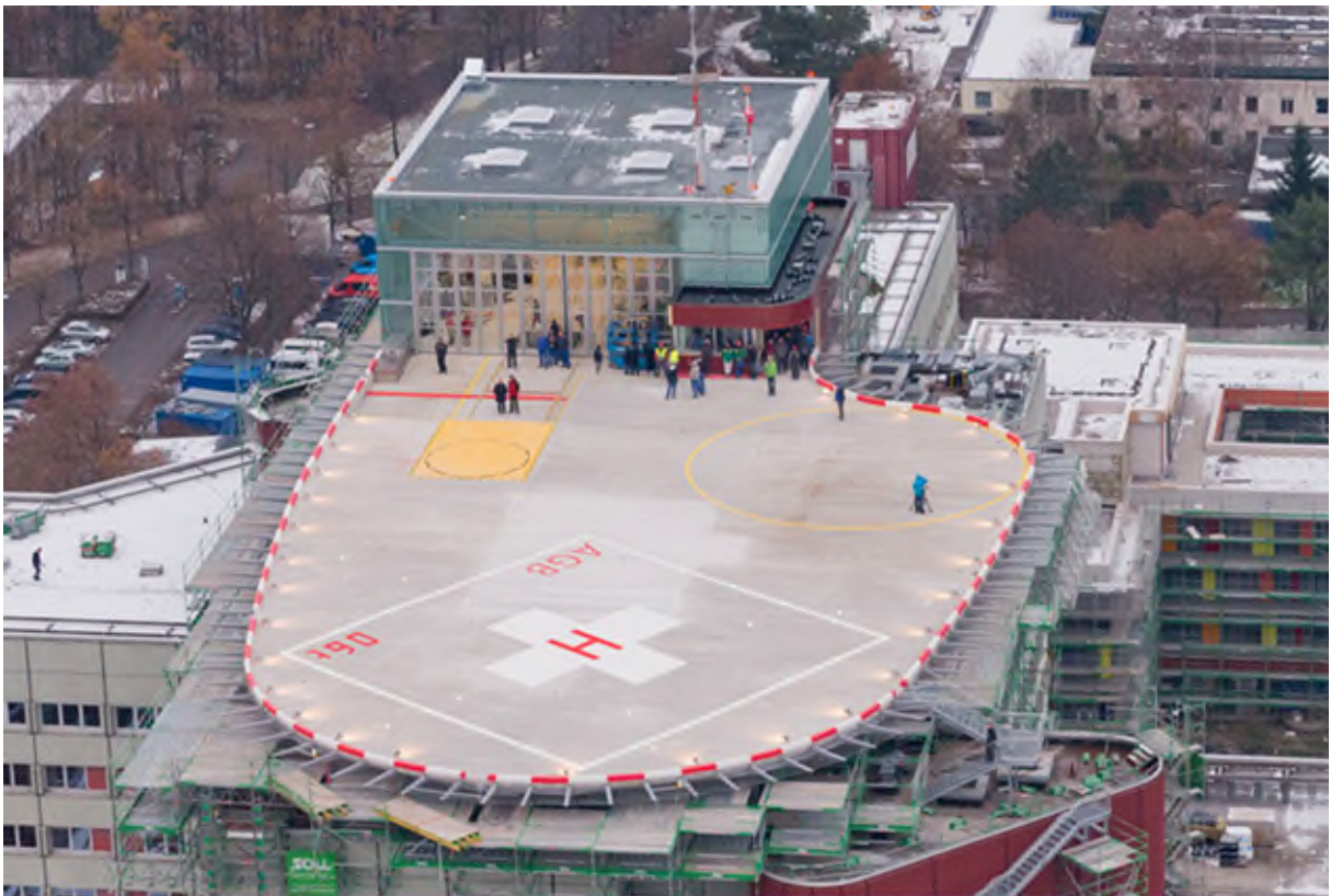
Abb. 2: Übersicht des Hubschraubersonderlandeplatzes mit Hangar
