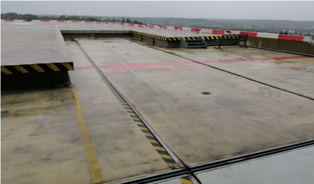
Abb. 3 Blick vom Hangar zum „Bahnhof“ der Plattform
