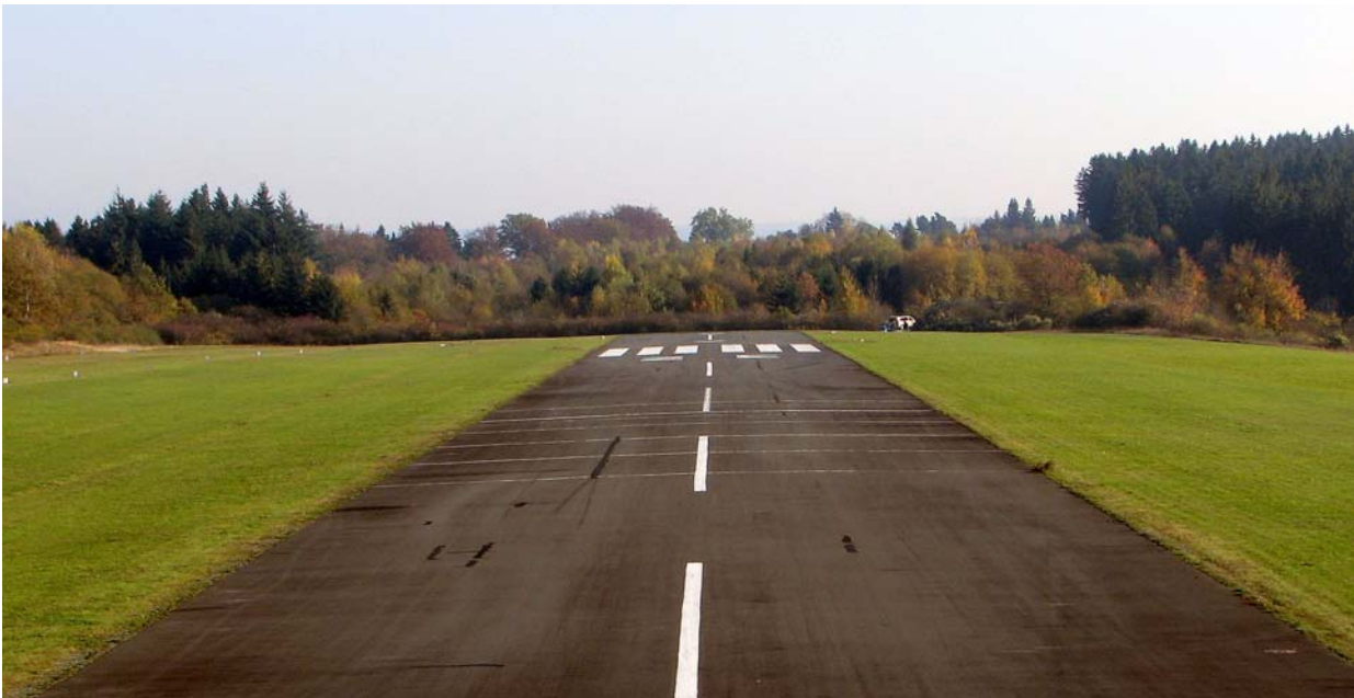
Bereich der Unfallstelle im Abflugsektor der Startbahn 14
