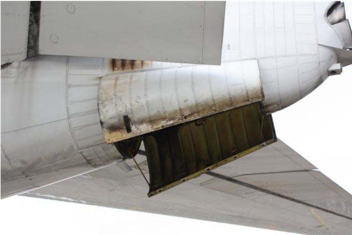
Gesamtansicht des APU Compartments
