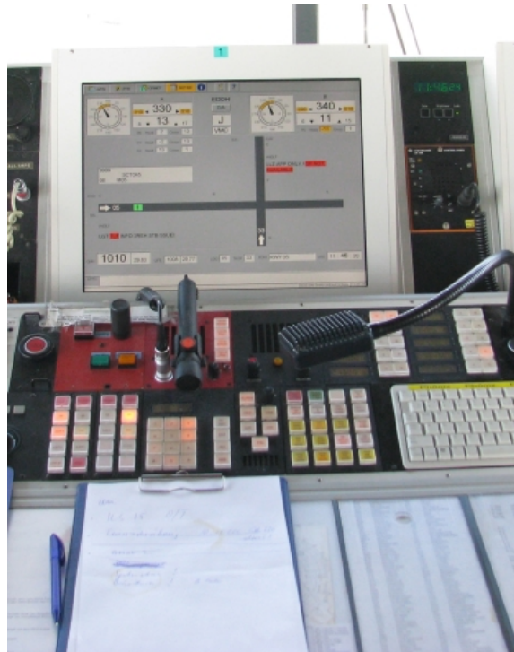
Anzeige der Windwerte am Boden am Arbeitsplatz des Platzverkehrs- und Rollverkehrsleuten (Quelle: BFU)
