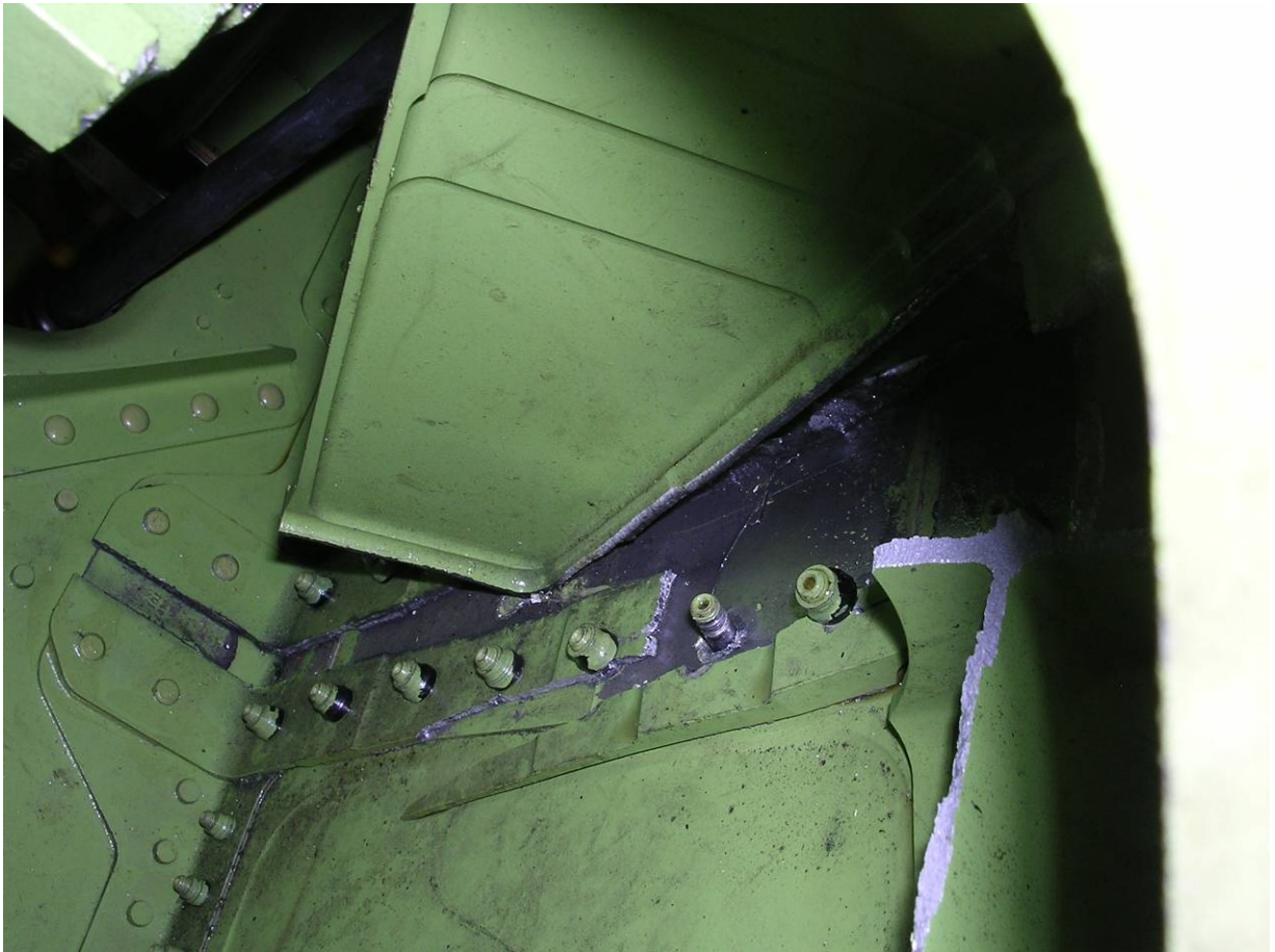
Bild 1: Rechte Tragfläche, herausgerissener Support Fitting
