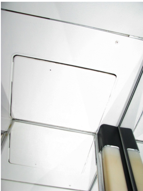
Klappe des Maskenbehälters der vorderen Toilette
