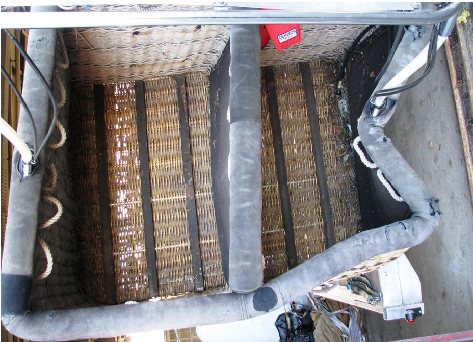
Deformationen des Metallrahmens in einem Korbabteil
