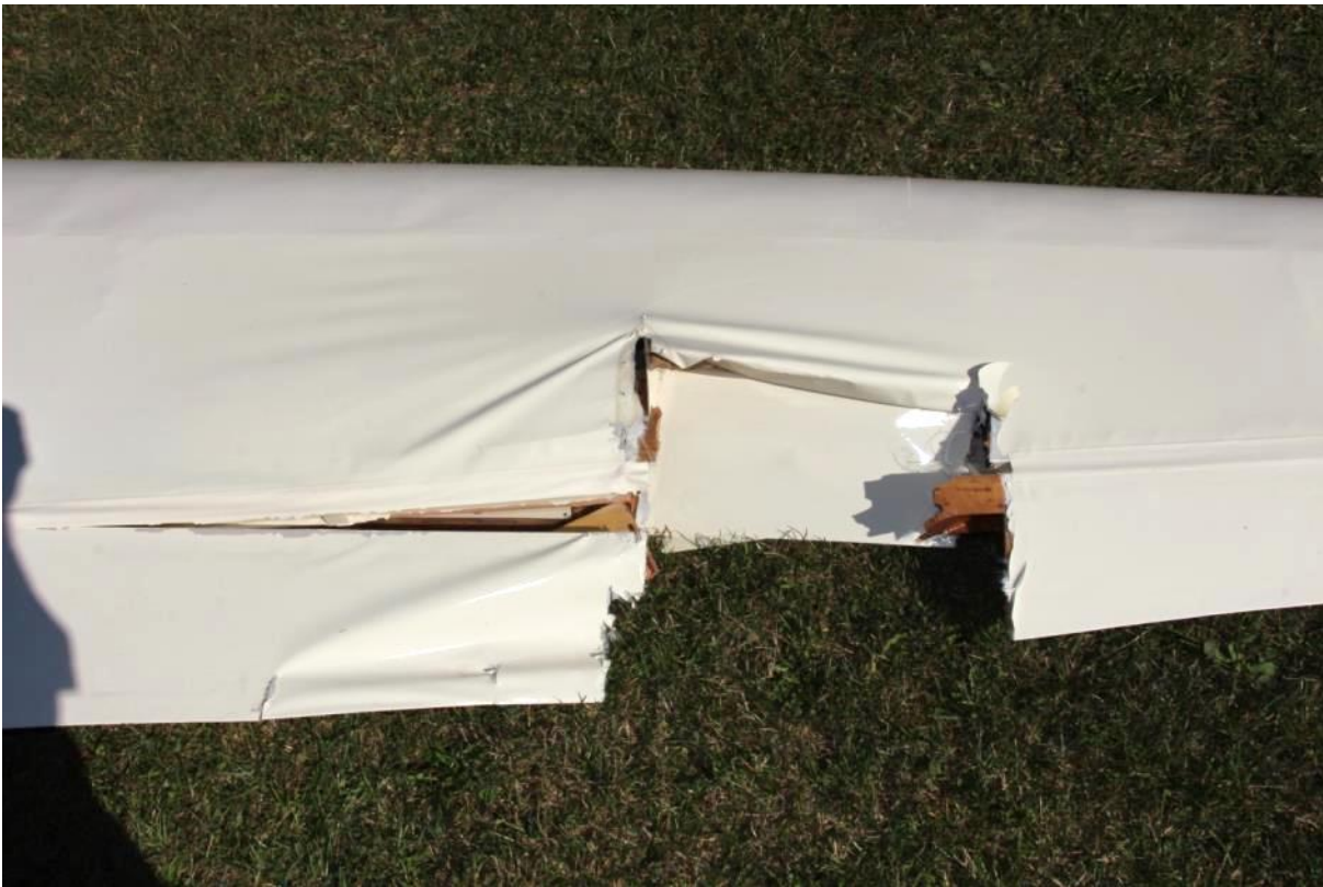
Schaden im Bereich der Querruderanlenkung
