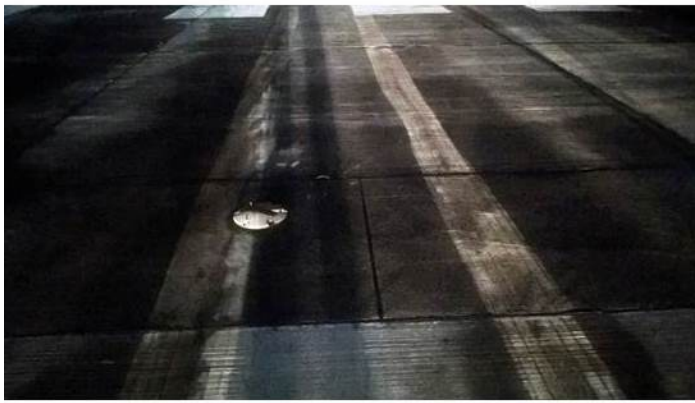
Fehlende Pistenschwellenbefeuerungslampe
