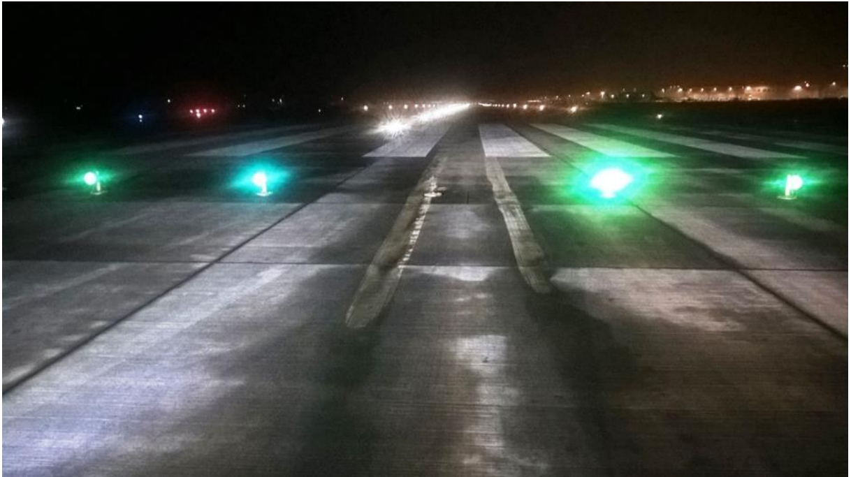
Aufsetzspuren des rechten Hauptfahrwerks
