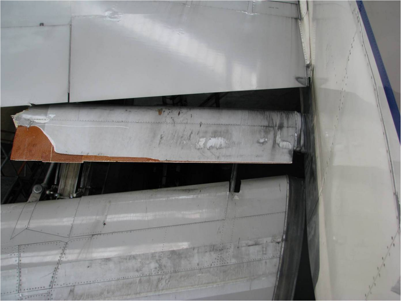
Anlage 2: Einklemmter Teil der verbliebenen Landeklappen
